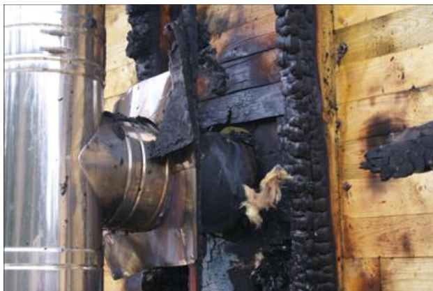
Skorstensrörets genomföring i ytterväggen sedd utifrån
