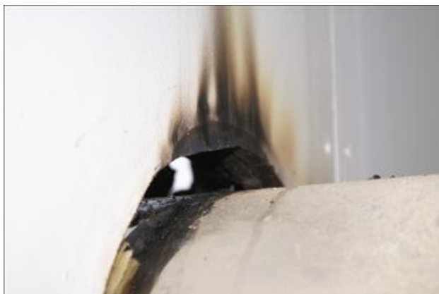
Skorstensrörets genomföring i ytterväggen sedd från insidan av pannrummet
