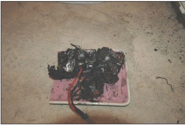
Figur 1 Bild av det brandskadade batteriet
