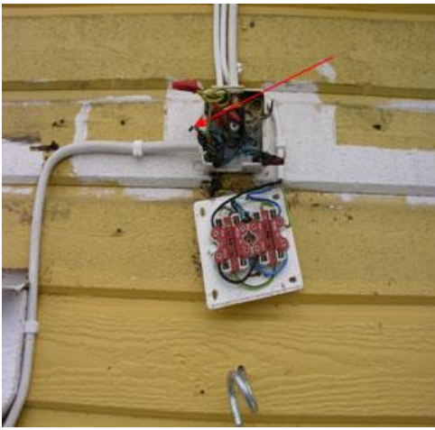
Bild 1 visar eldosan ute på altanen där pilen markerar området för den inträffade överlagsskadan och bild 2 visar eldosan i köket samt den brandskadade väggen och det brandskadade taket.
