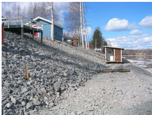
Slänten i Råbäcken efter förstärkningsåtgärder.
