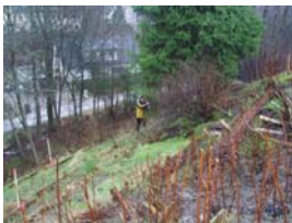
Åtgärder vid akut skredrisk för småhus Torpadal, Lerums kommun
