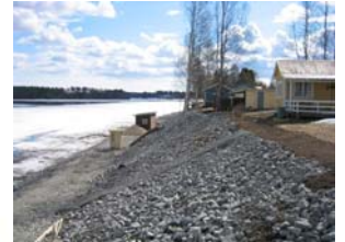
Förstärkning av slänt vid småhus Råbäcken, Bodens kommun
