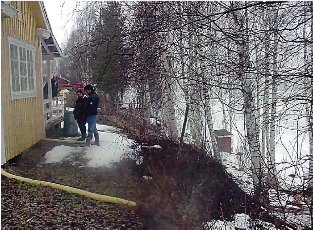
Slänten i Råbäcken före åtgärd.
