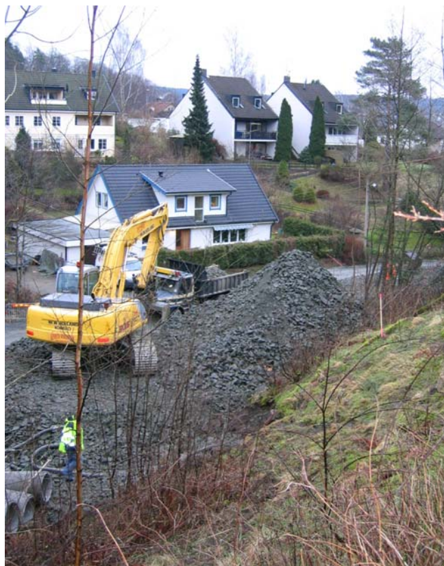
Utläggning av stödfyllning.
