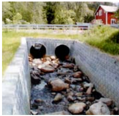
Åtgärder mot ras och erosion i moränslänter Kvarnbäcken, Sysseleback Torsby kommun
