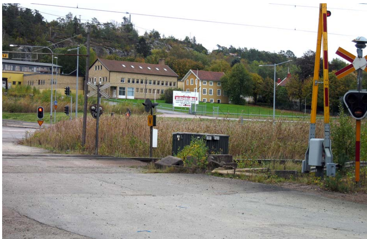
Nivåskillnaden i området är 20 m från fastmark till Rv 45. Jorden utgörs av successivt ökad lermäktighet till 20-25 m. Här finns även kvicklera, som vid vibrationer eller schaktning helt kan förlora sin hållförmåga.
