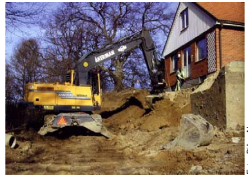
Avschaktning av slänt.
