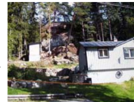
Förstärkning mot bergras Skriketorp, Norrköpings kommun
