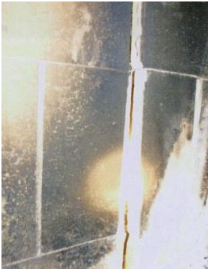
Bilden visar det 255 mm eldfasta teglet som gick att plocka bort med händerna.
