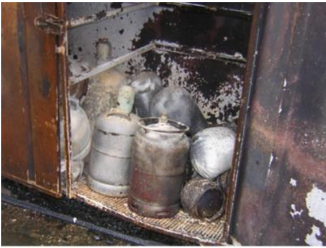
Några av gasolflaskorna som förvarades i skåpet.
