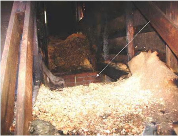
Reglar och spånfillning frilagts som låg över en del av skorstenen i bjälklaget
