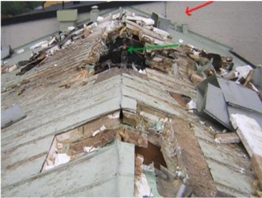
Den röda pilen visar avskiljande vägg mot gymnastiksalen. Nedanför den gröna pilen startade branden.
