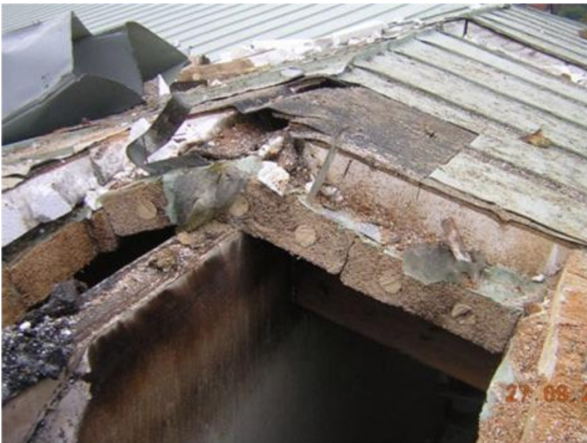
Takkonstruktionen i genomskärning. Träarmeringen.
