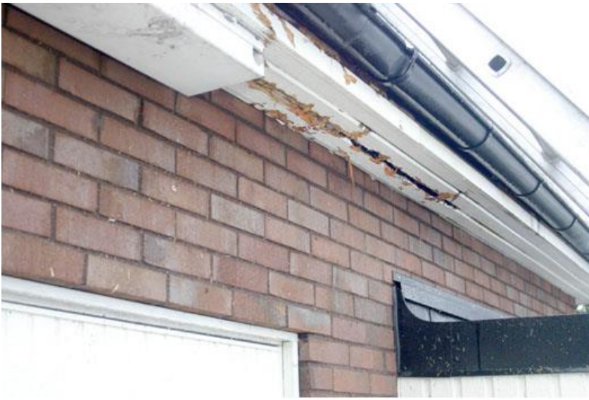
Så här ser det ut där skärsläckaren använts. Innanför teglet spreder branden upp till vinden.
