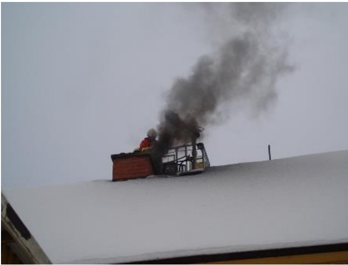
Arbete med kulan i skorstenspipan
