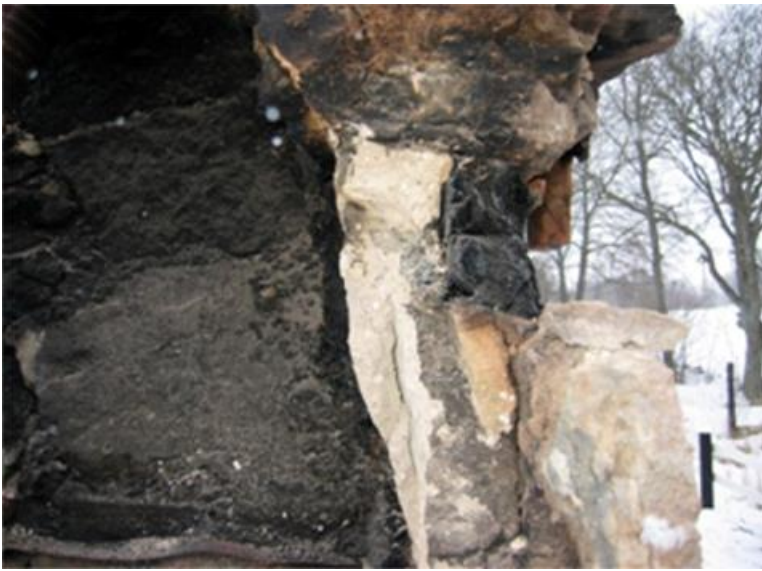
Träbjälke inmurad i skorstenen.
