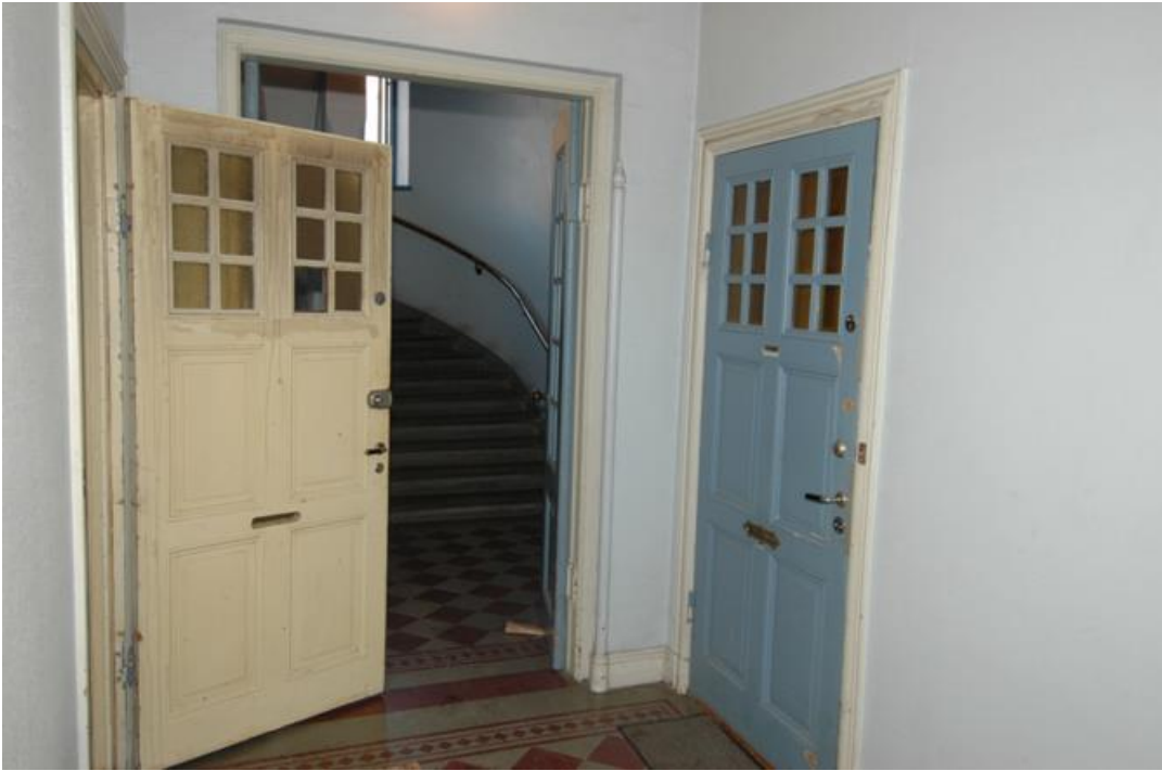
Vanligt fönsterglas i lägenhetsdörrarna
