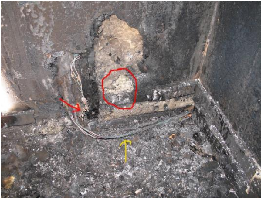
I röda ringen är brandstarten i vägguttaget. Röda pilen visar vägguttag. Gula pilen visar elkablar till spis och till värmeelement i vardagsrummet.
