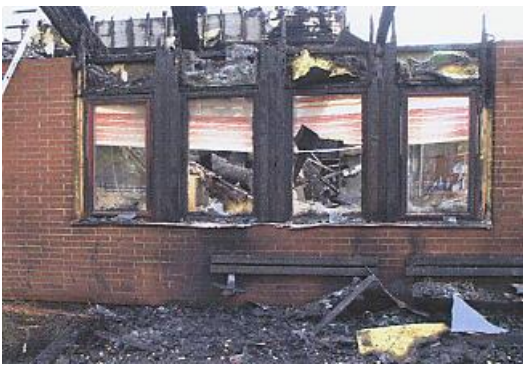
Platsen där branden startat. Denna plats var den enda där panelen mellan fönstren hade brandskador.
