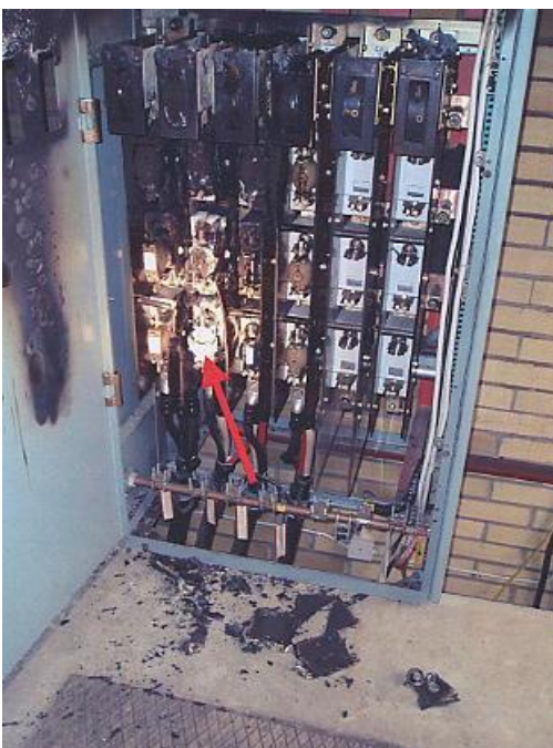
Fyra av sex grupper är nyttjade. Lägsta brandskada utgår från säkring av grupp två.
