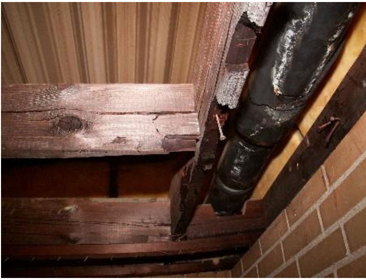
Delar av regeln fattar på grund av torrdestillation.
