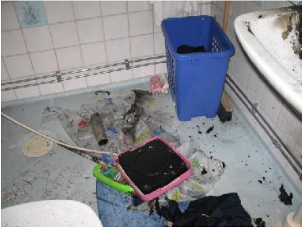
Duschrummets golv har lite brandskador. En sprayflaska som har exploderat syns på bilden.
