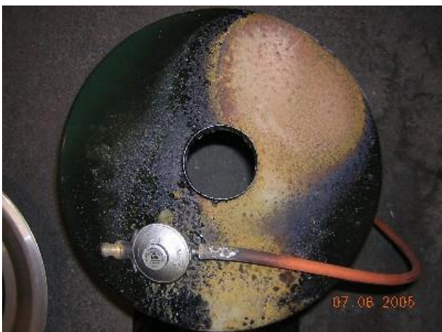
Gasolslangen saknar klämring/slangklämma och är brandskadad.
