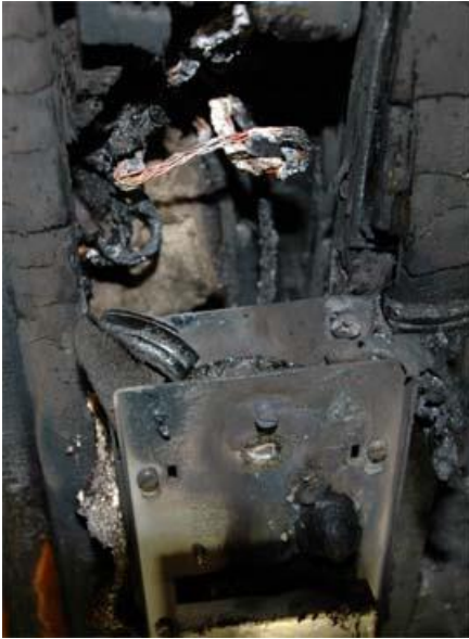
Dimmer infälld i vägg.
