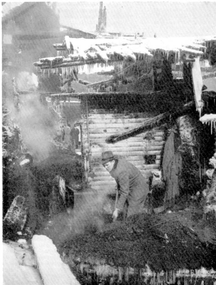
Bild 2. Bilden hämtad från häftet "Brandorsaksundersökning" år 1952. Lägga märke till att undersökaren arbetar i hatt och kostym och att trenchcoaten prydligt hängts upp på väggen.
