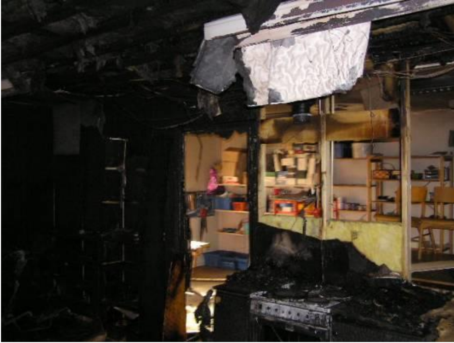
Spisen där branden startade, här syns även rummet bakom köksrummet där dörren varit stängd emot.
