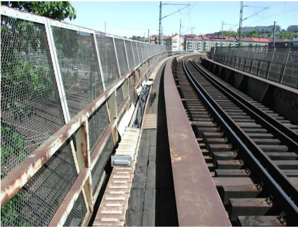
Brandplatsen: Kolade träplank, brända kablar och bränd glasfiberkanal.
