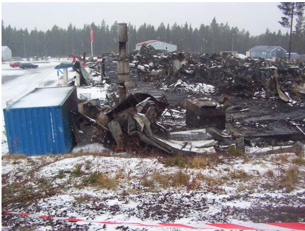
Bild 1: Bild tagen över fastigheten från nordost. I bildens mitt syns fastighetens rämnade brännoljetank (Foto: Räddningsverket)
