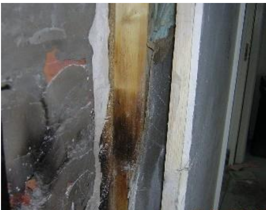
Bilden visar att luftat utrymme saknats bakom eldstaden.
