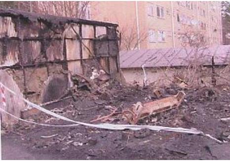
En enkel vägg har fungerat som brand-avskiljning.
