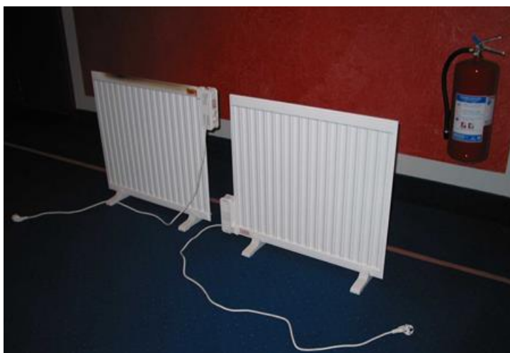
Vänster - felmonterat Höger - rättmonterat
