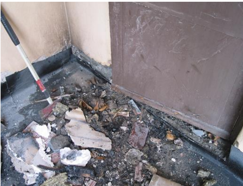
Här användes gasol vid tjärpapp.
