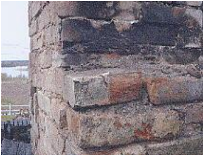
"Hylla" där bjälklag vilade.
