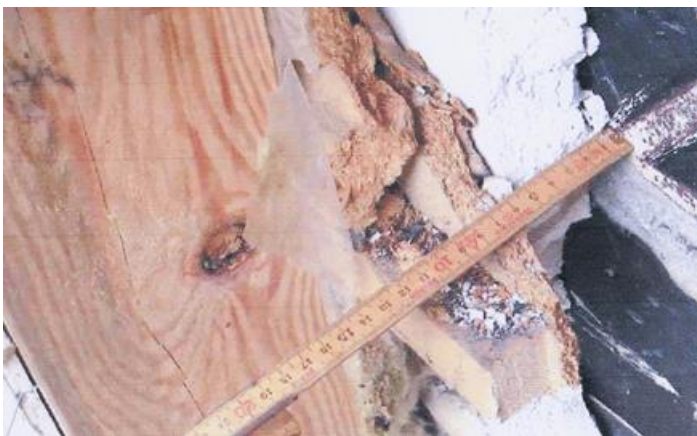
Avståndet från värmeskölden till spånskivan är ca 60 mm, med två gipsskivor à 13 mm bara 35 mm.
