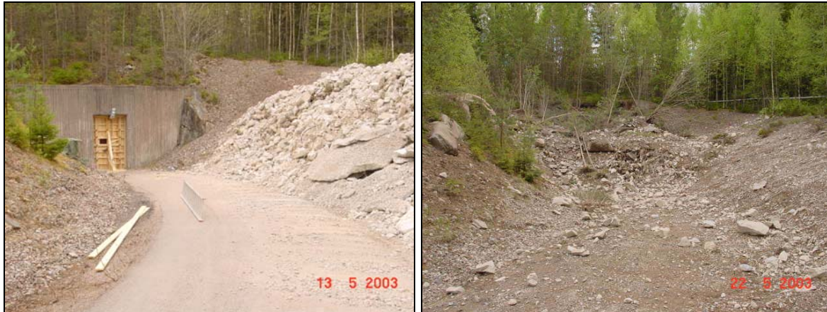
Bild 3-4. Huvudingången före och efter explosionen (observera att huvudingången täckts med fyllnadsmassor efter fototillfället den 13 maj)
