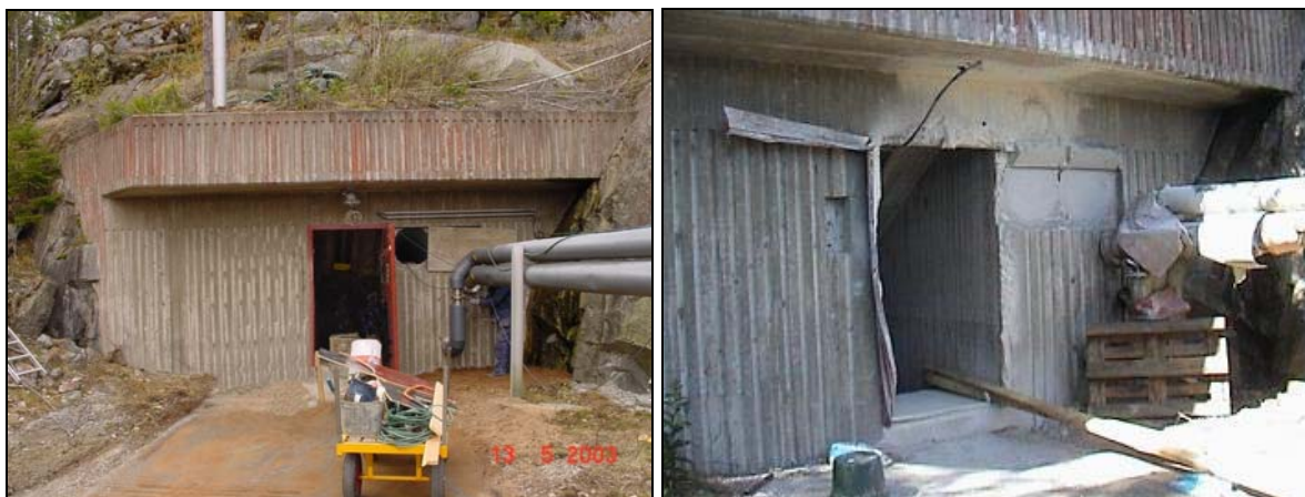
Bild 5-6. Reservutgången före och efter explosionen
