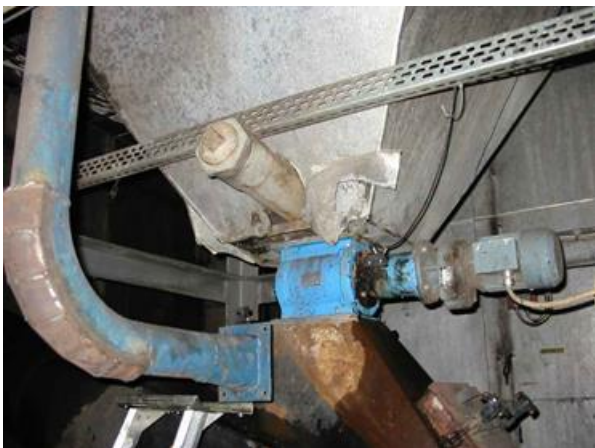
Mutter som ska lossas vid rensning.
