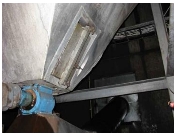
Rensluckan vi öppnade.
