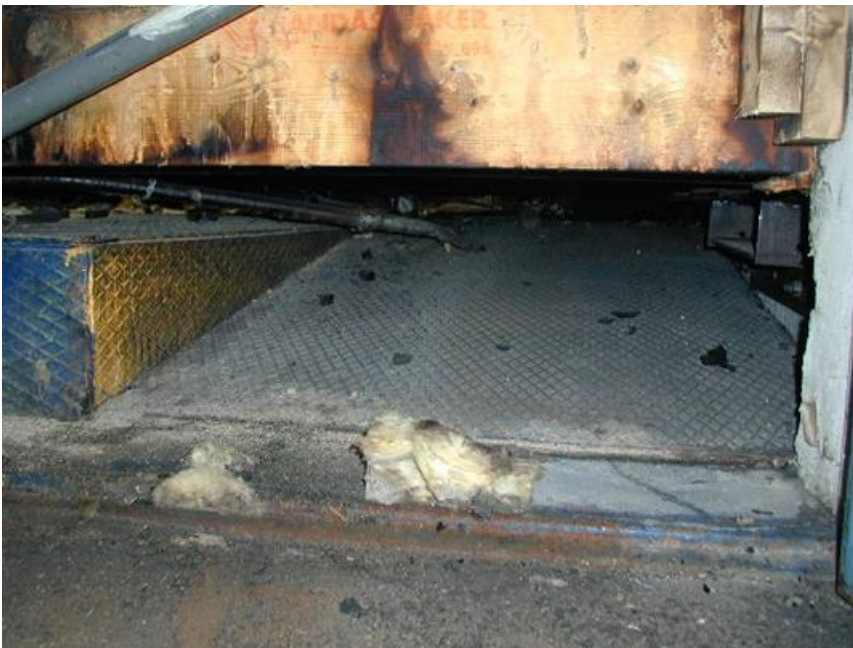
Golvkonstruktionen. Träreglor överst som hängde på stålkonstruktion. Luftspalt och sedan viss isolering för att avslutas med ett plåtgolv som var det befintliga golvet innan bageriet anordnades.
