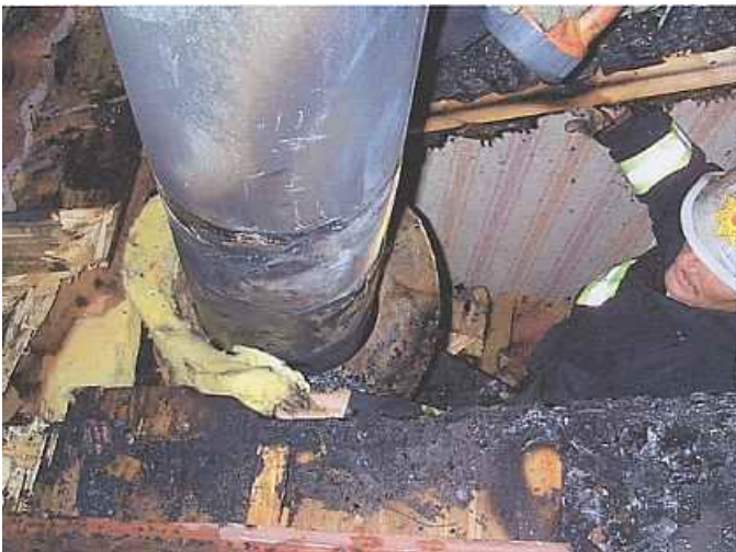
Genomföringen mellan två takstolar.
