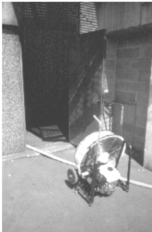
Figur 8. Fläkt placerad fram dörr till trapphuset.
