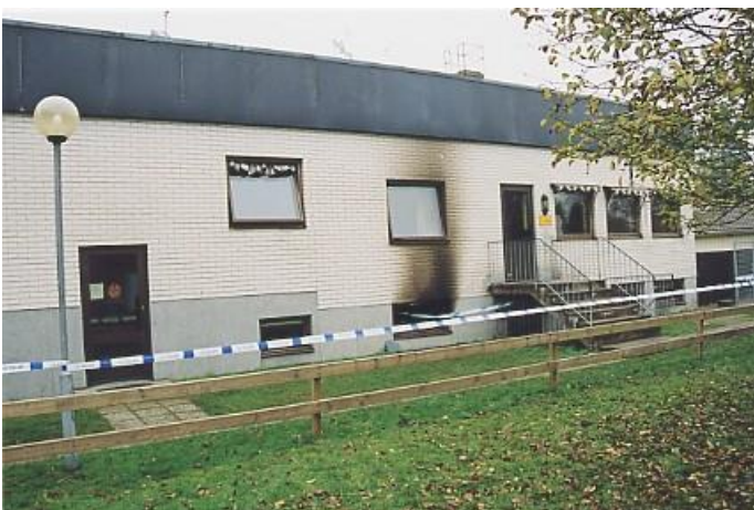
Bild 3. Fasad på byggnadens östra sida, sotfana efter källarbrand.
