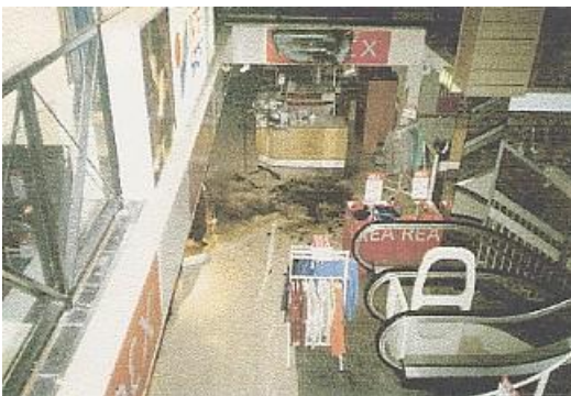
Visar skylten där branden startat, samt avbränning i golv från nedfallande kläder som hängt på klädställningen.
