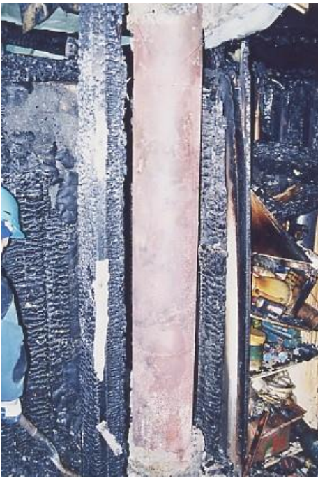
Bilden visar skorstenen i schaktet på översta våningen.
