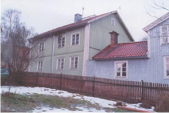
En bild på hur tätt kåkarna ligger. Branden har varit i det gröna huset på andra våningen.
