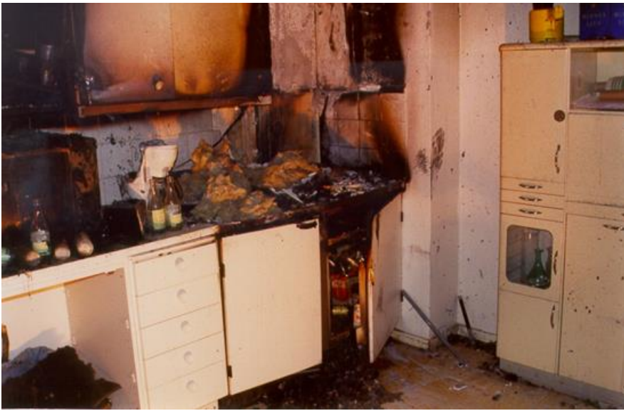
En bild av det brända trinettskåpet.
