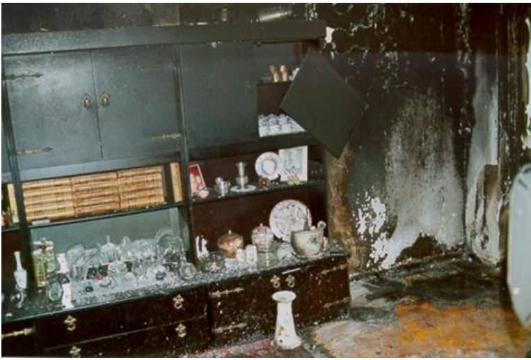
På bilden syns det att branden har börjat lågt. Till höger om primärbranden har balkongdörren stått på glänt.
