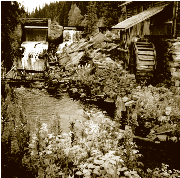
Äldre kvarn. Rördåfors kvarn i norra Värmland är ett gott exempel på den enklare typen av kvarnar som inledde vattenkraftepoken i Sverige.
