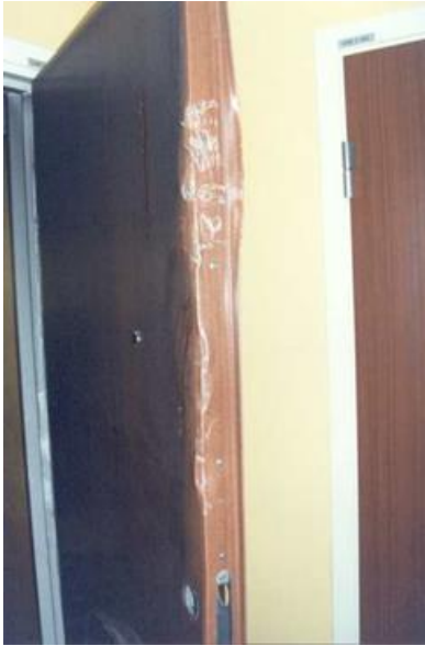
Säkerhetsdörren efter räddningstjänstens forsering.
