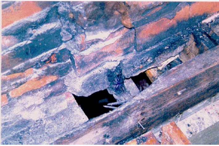
Kraftig förkolning på en ingjuten träregel.
