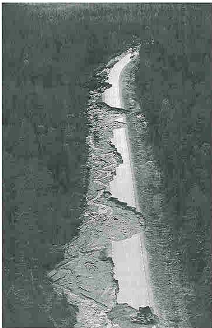
Bild 1. Delar av väg 373 mot Arvidsjaur spolades bort p.g.a regnet Foto Gunnar Westergren
