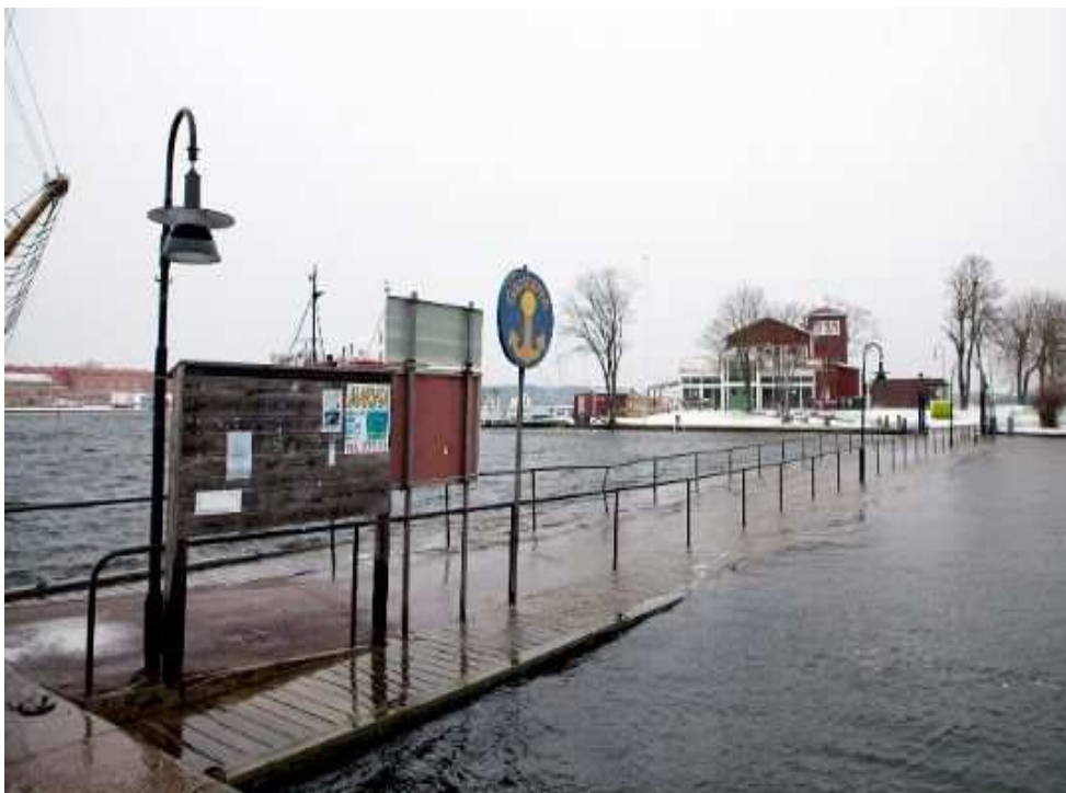
Bild 7. Badholmen, Oskarshamn, den 4 januari 2016. Under stormen nåddes ett nytt vattenståndsrekord i Oskarshamn som mätte 116 cm över medelvattenståndet. Detta
