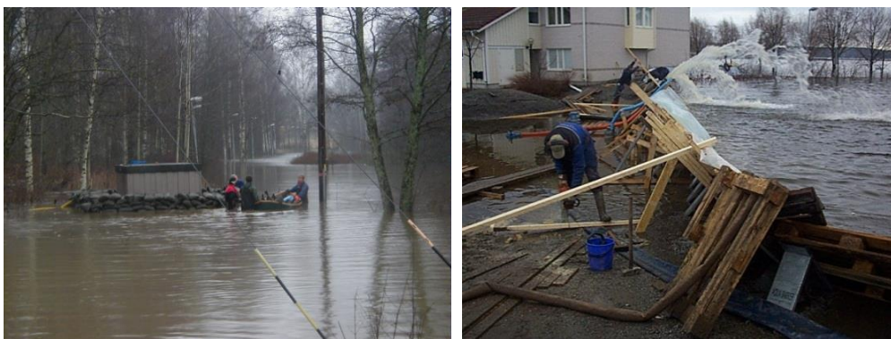
Figur 4 Exempel på foton av åtgärder. Invallningar av en transformatorstation i Arvika 2000.
