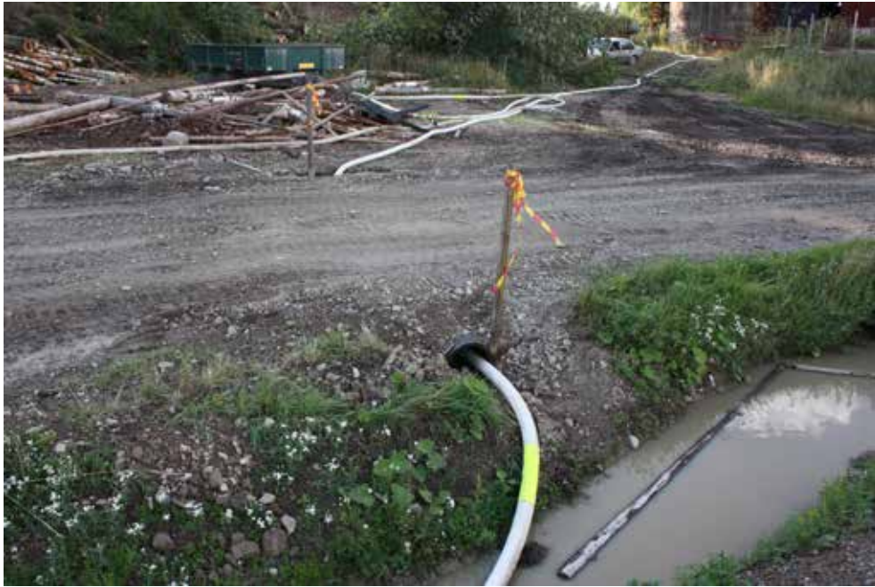
Slang och rör under skogsväg.
