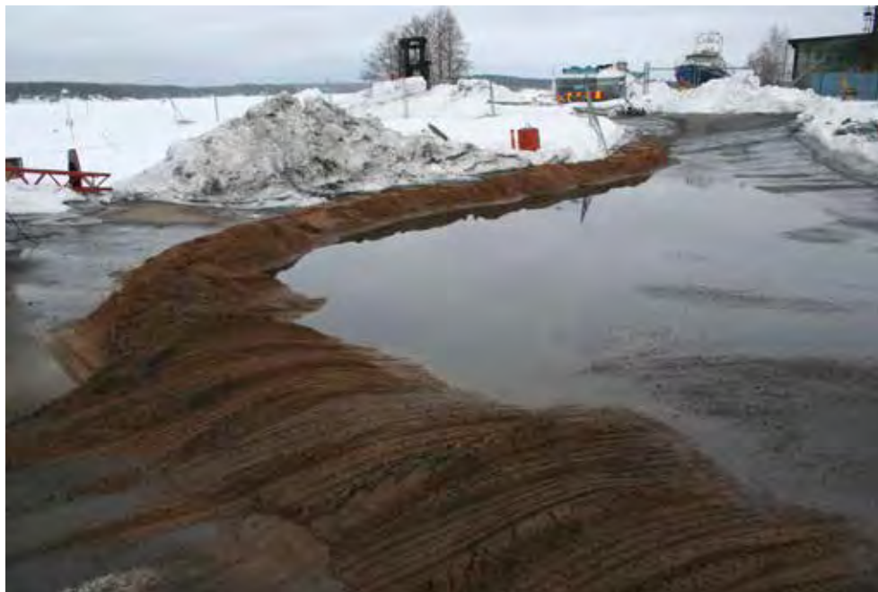
Tillfällig invallning med sand för att motverka spridning av kontaminerat släckvatten. Foto: Claes-Håkan Carlsson, MSB
