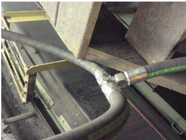
Bild 5: Den stålarmade hydraulslang som användes till kvävgasen under inerteringen, efter AGAs egen stålomspunna slang.
