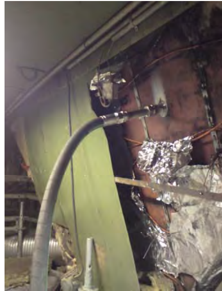
Bild 4: Lansen inmatad i den avklädda cisternen. Motsvarande fanns i den andra struten.
