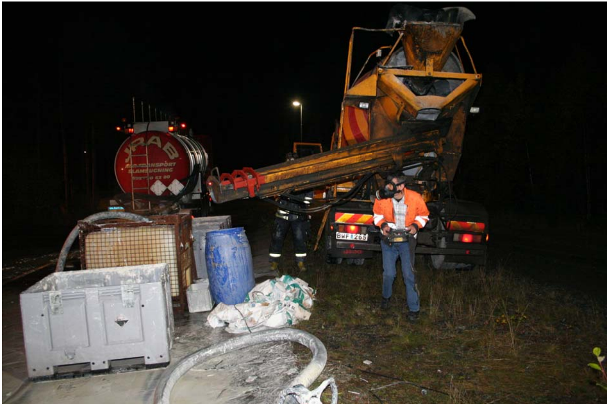
Figur 2 Tillredning av kalkslurry i cementbil
